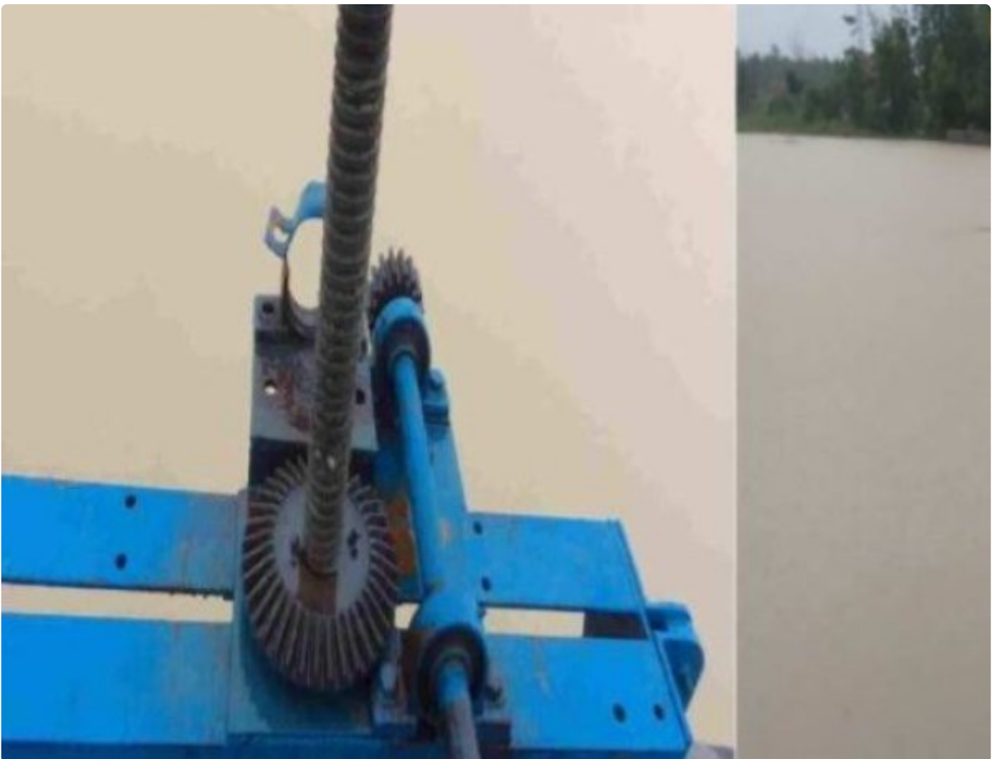
Pintu air Albaret Simpang Mesuji
